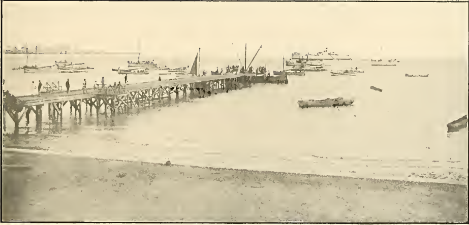
Ancien pont de Bissau (Pilotis de «Cibes»)
